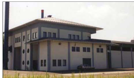
Abb.1: Fernheizwerk Güssing (Quelle: Foto Muik)
