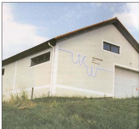
Abb. 11: Fernwärme Unterkoahlstätten (Quelle: Babbi)
