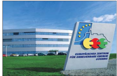
Abb. 4: Technologiezentrum Güssing (Quelle: Foto Muik)
