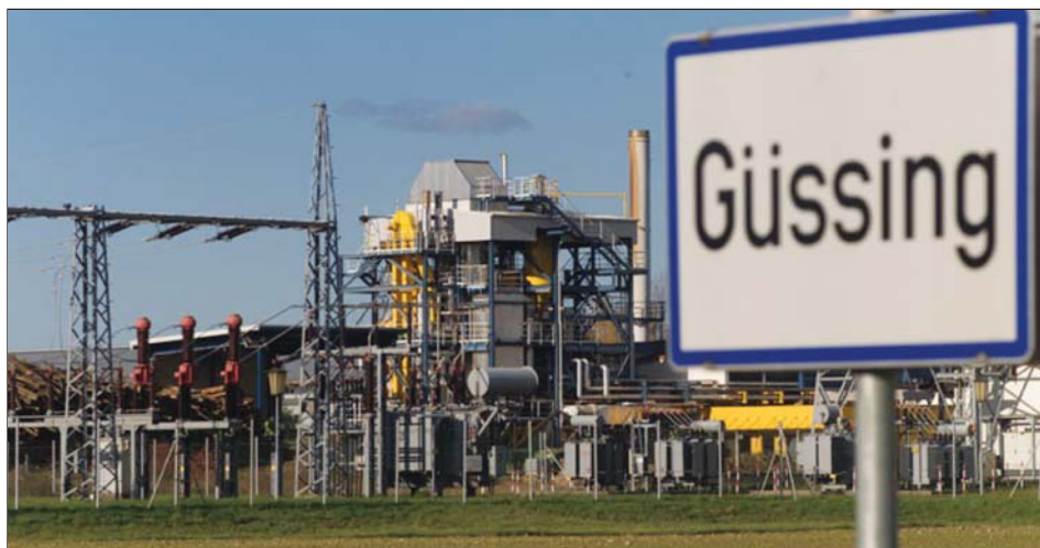
Abb. 3: Biomassekraftwerk Güssing (Quelle: Foto Muik)
