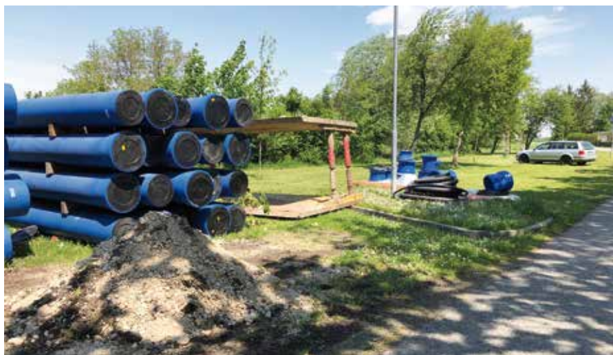
■ Rohrlager im Bereich Stöttera bei der Sanierung der TL 150 und 151 Antau – Stöttera
